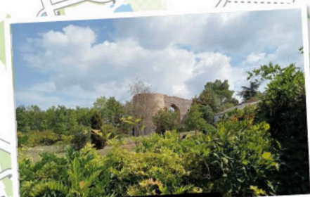
Ancien four du Montru
