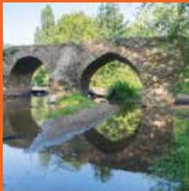
Ce pont, qui chevauche la Sanguèze dispose de 4 arches et chacune de ses piles est flanquée d'un éperon. En aval cet éperon ne s'élève pas jusqu'au tablier ; en amont au contraire, il s'élève au-dessus de lui ce qui donne à ce pont un aspect tout particulier et le rend
